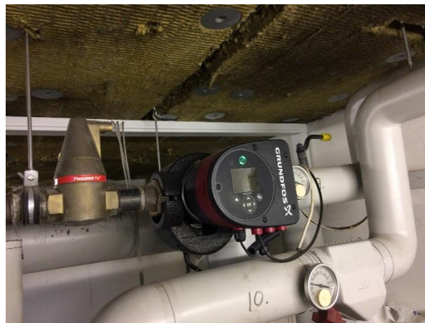
Cirkulationspumpe.
