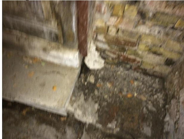
Kældergulv m vandvulst.
