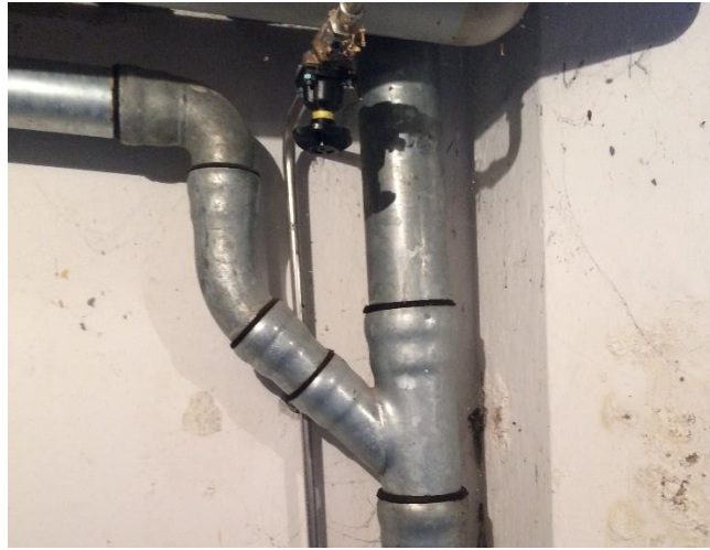
Faldstamme i kælder.
