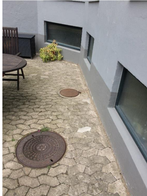
Belægning langs facade
