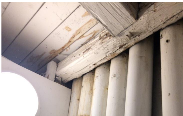
Aftrækskanaler i loftsrum.
