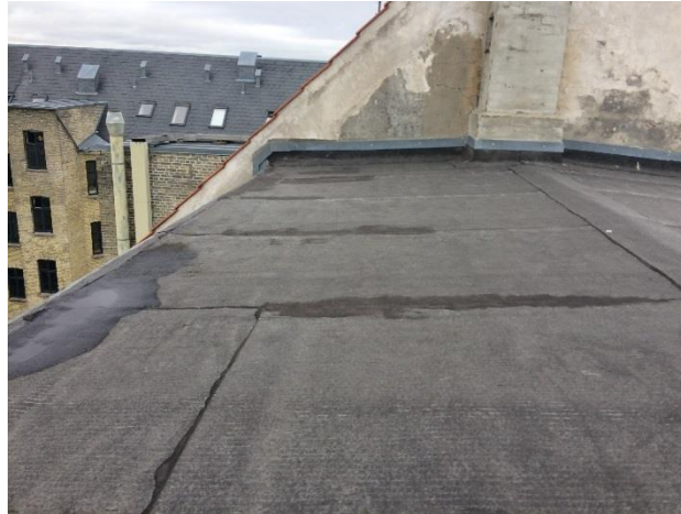
Flade del af med tagpapbeklædning.
