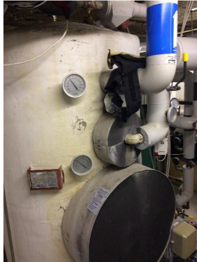
Varmtvandsbeholder.
