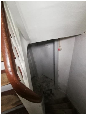
Bagtrappe ved kælder.
