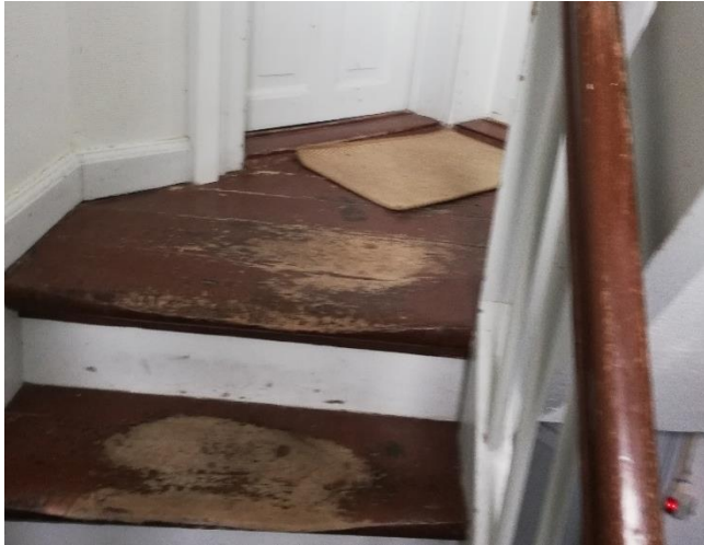
Bagtrappe ved bagdør til lejligheder.
