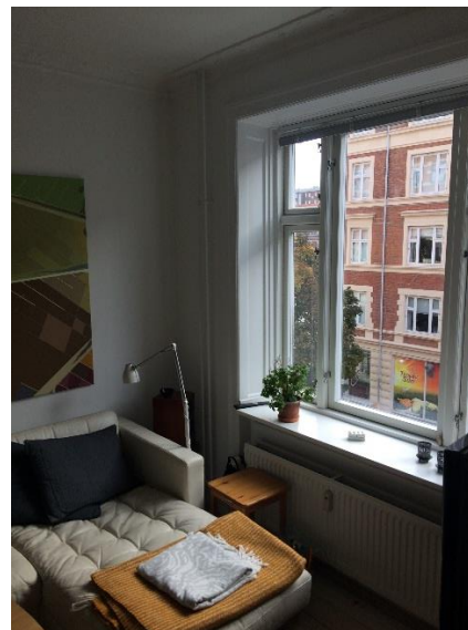
Radiator og stigestreng mod gade.
