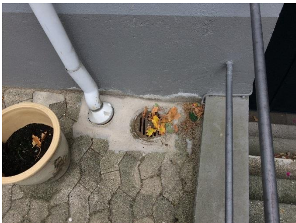
Afløb og nedløbsbrønd.
